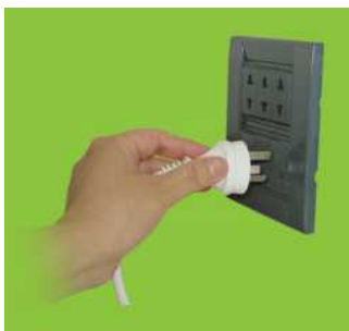
(c) 插头的地线插脚先进入插座
